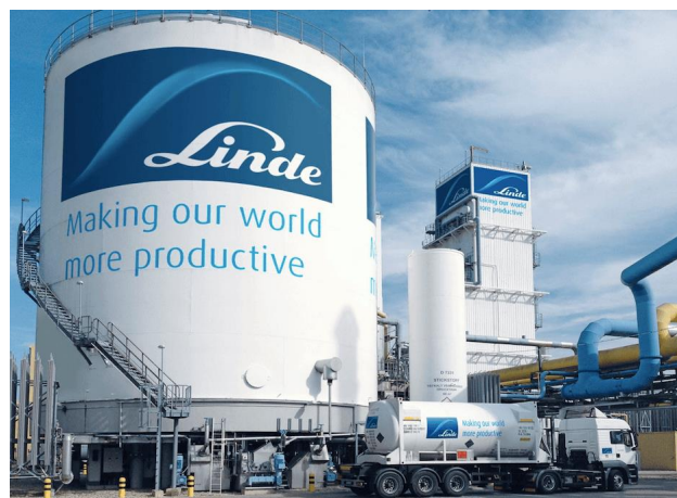
Lagringstank i stål. Bilde: Linde.
