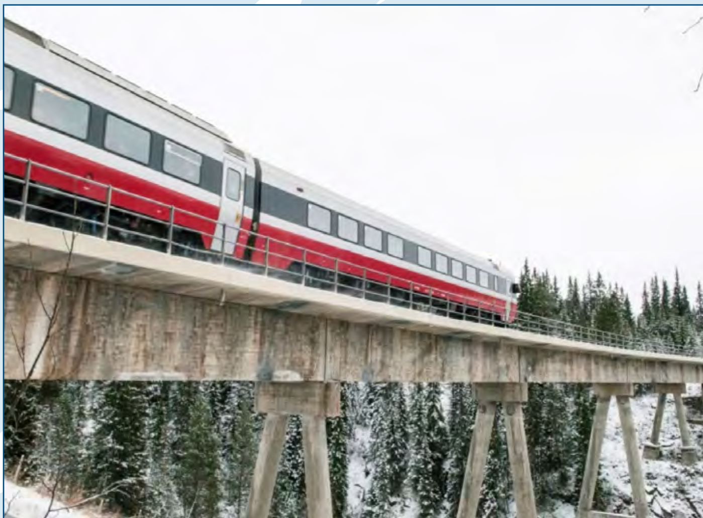
Rørosbanen er 382 kilometer lang og går fra Hamar gjennom Østerdalen og over Røros, gjennom Gauldalen til Støren. Foto: Jernbanedirektoratet
