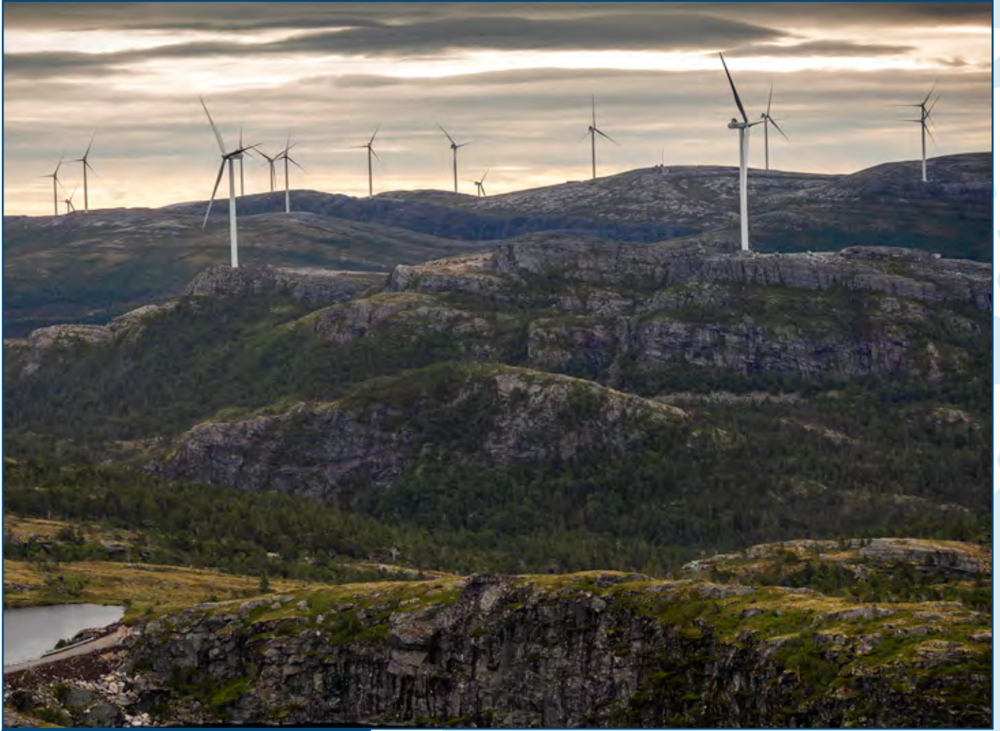
Roan vindpark under bygging. Foto: Vestas / Fosen Vind
